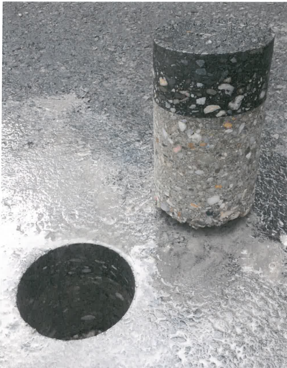
1. kép: Fúrást követően Nyíregyháza, Kosbor utca 0+280 km. sz. jobb oldal tengelytől 2,7 m
