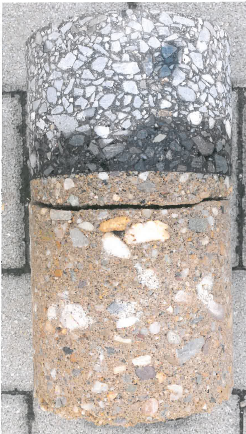
4. kép: Fúrt minta Nyíregyháza, Kosbor utca 0+110 km. sz. bal oldal tengelytől 1,2 m nyomvonal helyreállítás felett
